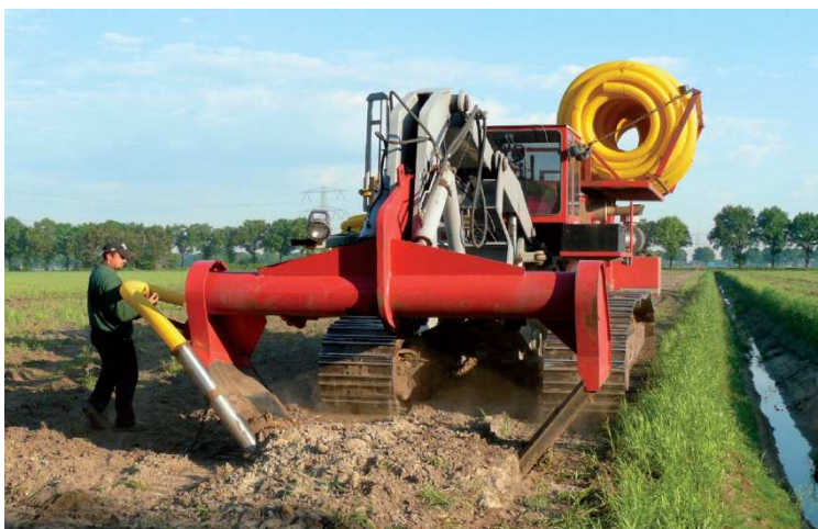
Afbeelding 3: Foto aanleg sleuven voor de drainagebuizen (Bron: RHDHV).
